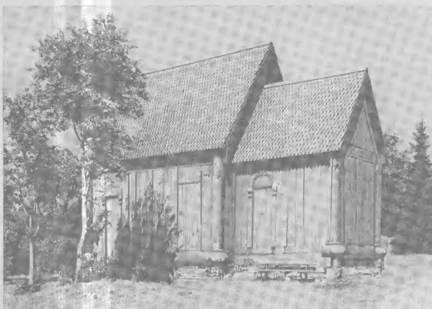
Рис. 13. Деревянная церковь XII в. (ставкирка)
