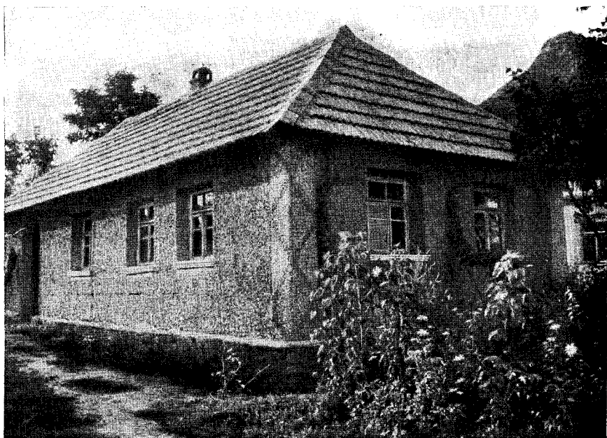
Рис. 1. Жилой дом колхозника с обработкой пилястр кирпичным боем красного и белого цвета, с. Лесоводы Городокского р-на Хмельницкой обл. (фото автора)
