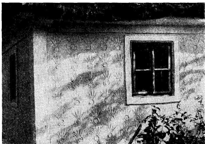
Рис. 2. Фактурная обработка стены: а — обработка пальцами, с. Клебань Тульчинского р-на Винницкой обл.; б — обработка штампом, с. Кадысвцы Каменец-Подольского р-на Хмельницкой обл. (фото автора)
