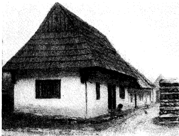
Рис. 3. «Длинный дом» в дер. Гомбаш Жилинской обл. (северная Словакия)
