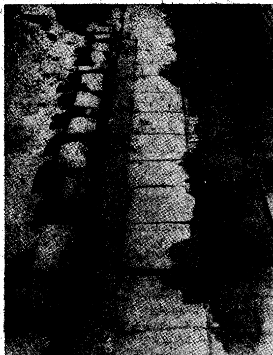
Рис. 6. Деталь отмостки у восточной стороны первого дворцового здания
