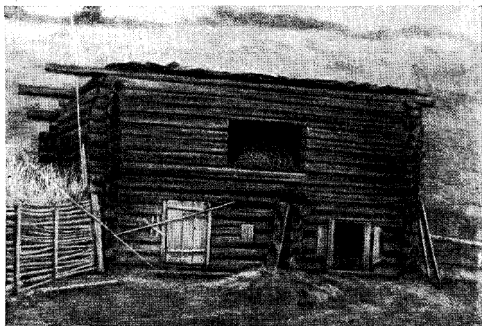
Рис. 11. Стайка и поветь с односкатным покрытием. Дер. Верхнее Суворово
