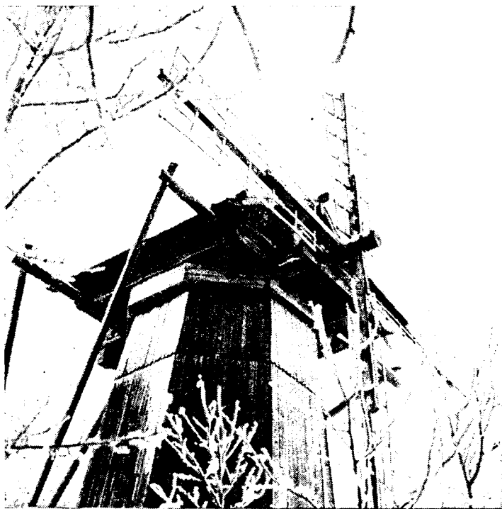
Рис. 2. Каргопольско-Онежский сектор. Мельница — «шатровка» из д. Кожпоселок
