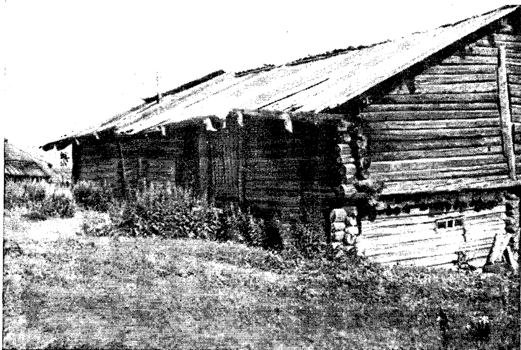
Рис. 1. Дом и двухъярусный двор (однорядная связь), середина XIX в., д. Сим
