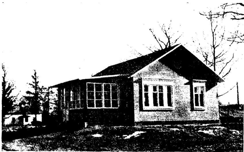
Рис. 10. Сборные стандартные домики из панелей заводского производства в сельхозартели «Заля земе» Огрского р-на
