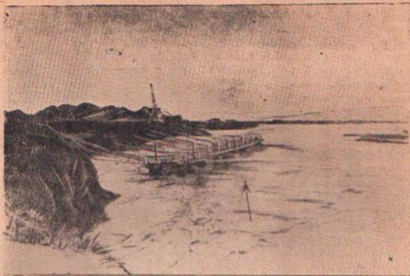
Рис. 2. Общий вид струенаправляющей установки из щитов проф. Потапова на р. Вахш перед головой Вахшеского магистрального канала. Вид вниз по течению
