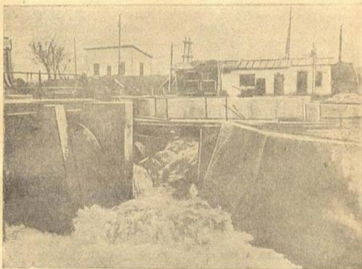
Рис. 7. Выход из лотка в перепад
