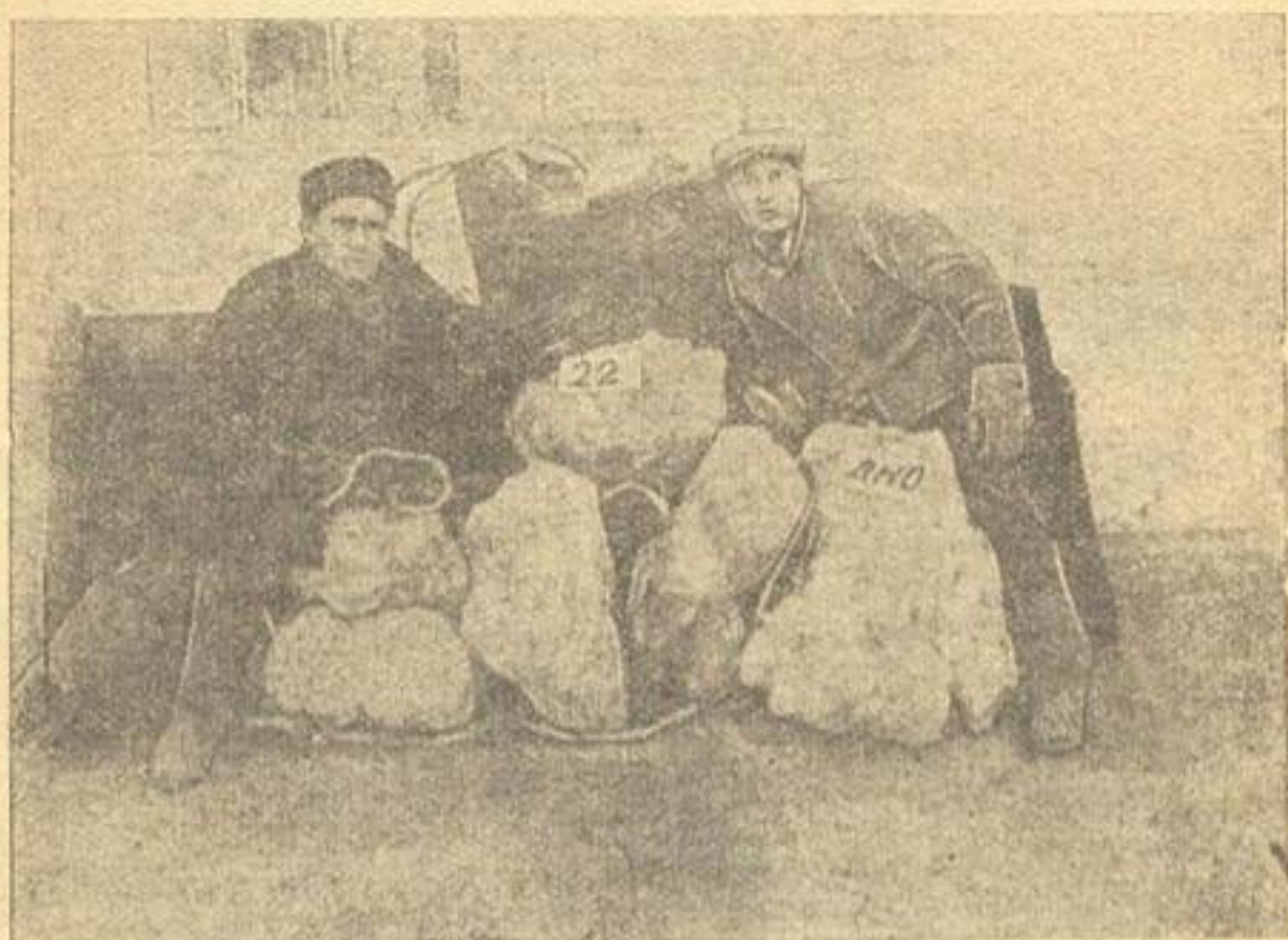
Рис. 3. Накопления прикрепленной шуги на контрольных веревках.
