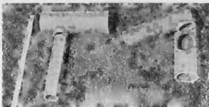
Рис. 8.24. Гончарные соединительные фасонные части (дырчатая и Г-образная соединительная трубы).
