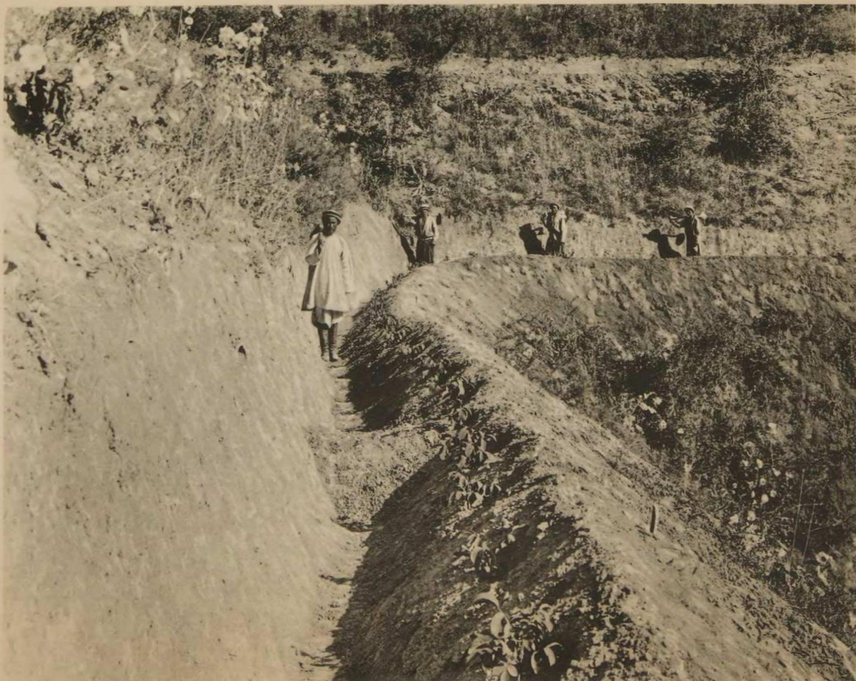
Терраса по горному склону въ 35^{\circ} . Впереди первого, стоящаго въ канавѣ террасы рабочаго, видна перемычка террасы и видны посаженные по валу террасы 1-лѣтніе саженцы грецкаго орѣха.
