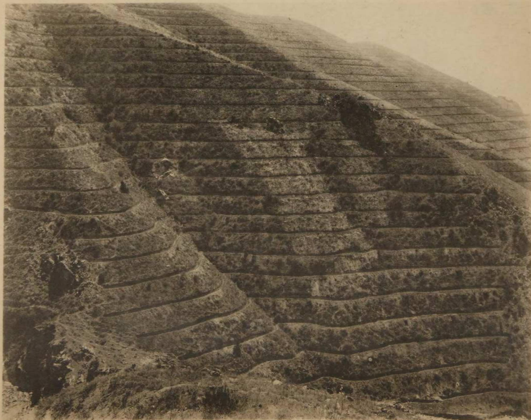
Террасировка горных склоновъ въ 25-40^{\circ} , при разстояніи между террасами, по перпендикуляру, въ 3 саж.
