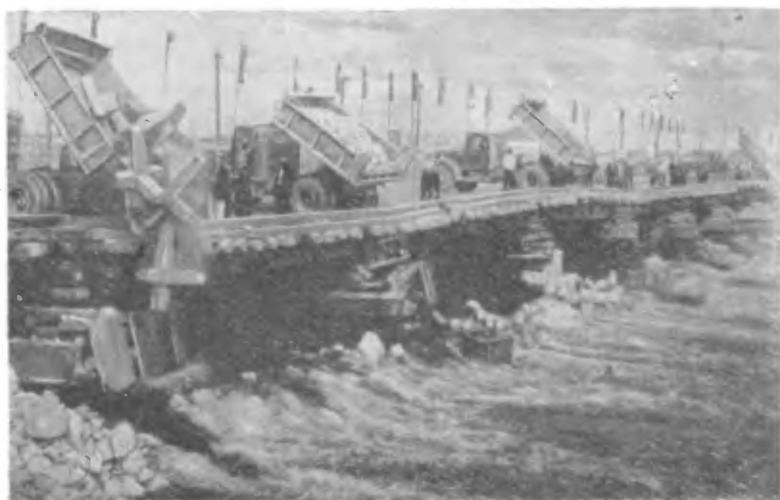
Рис. 34. Фото каркасной наброски Горьковгэсстроя.
