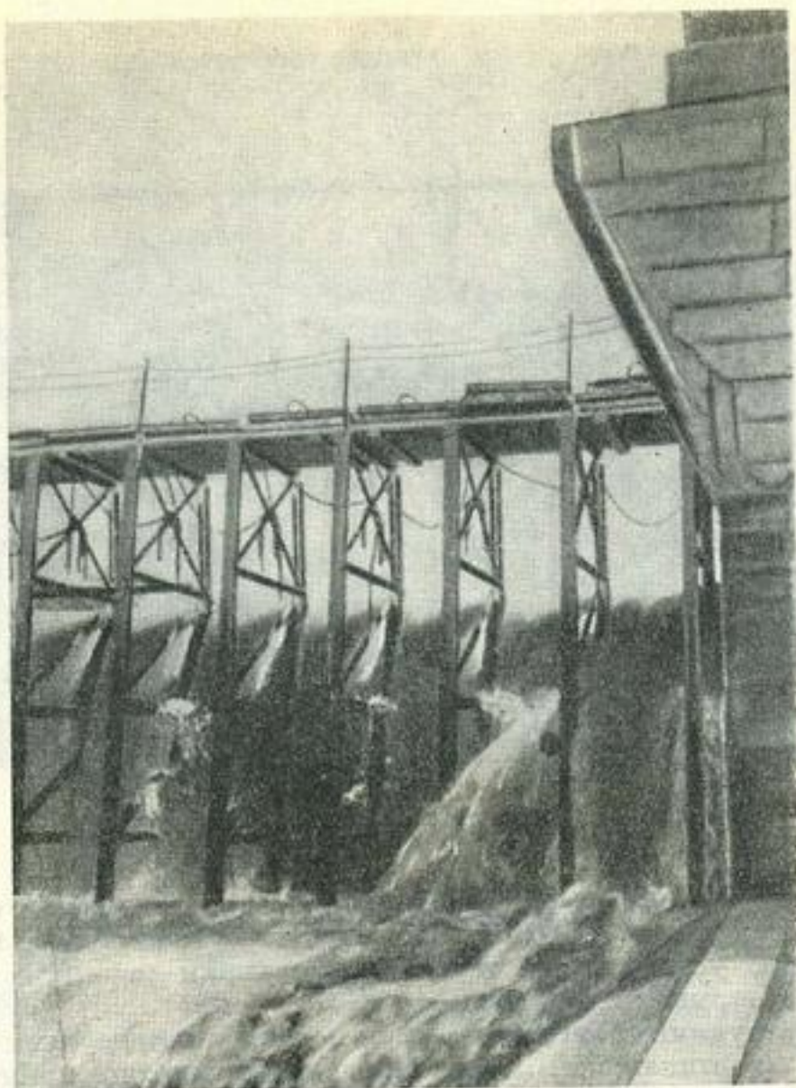
Рис. 9—5. Нижний бьеф плотины с поворотными фермами.
