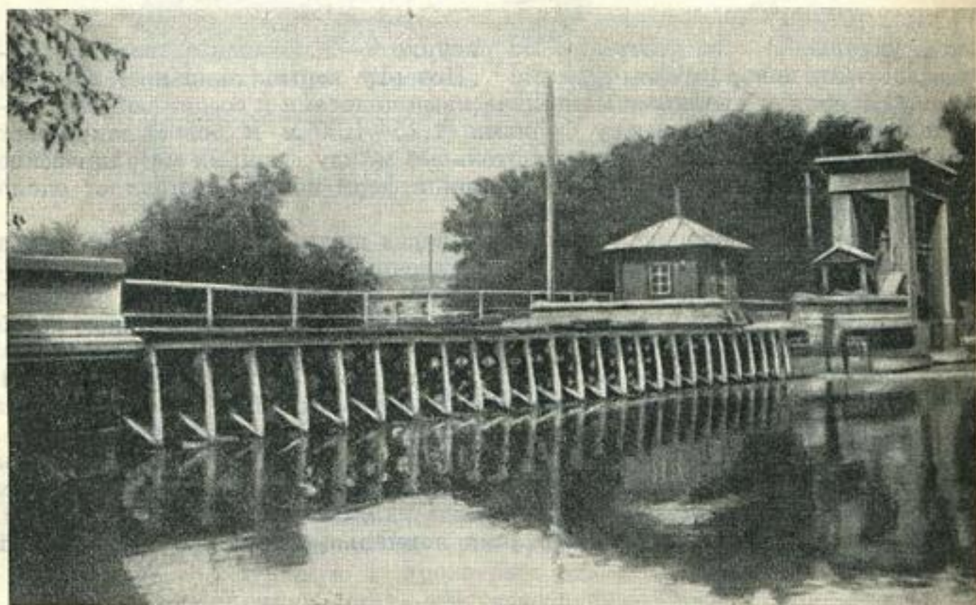
Рис. 9—4. Верхний бьеф плотины с поворотными фермами.
