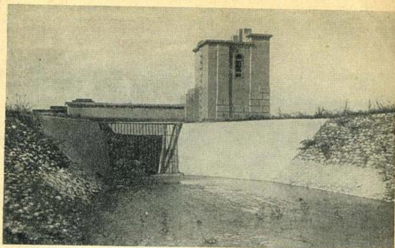
Рис. 5—21. Выходной оголовок дюкера.
