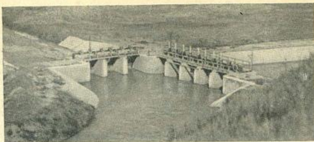
Рис. 2—4. Узел регуляторов на оросительном канале.
