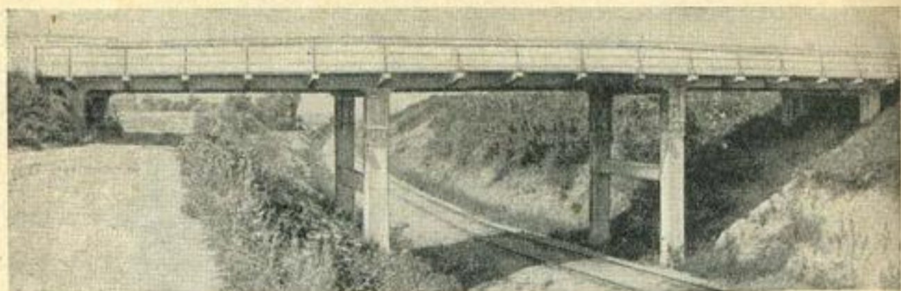
Рис. 5—11. Акведук на рамных опорах над железной дорогой.
