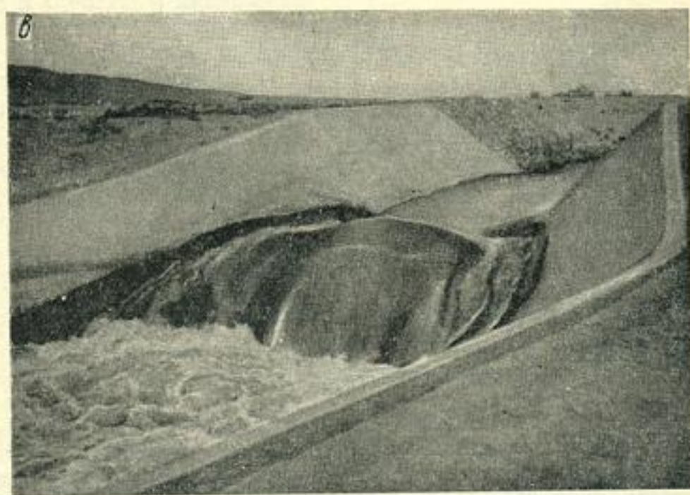
Рис. 6—12. Перепад с расщепительной балкой: а — расчетная схема; б — расход менее \frac{2}{3} расчетного; в — расчетный расход.
