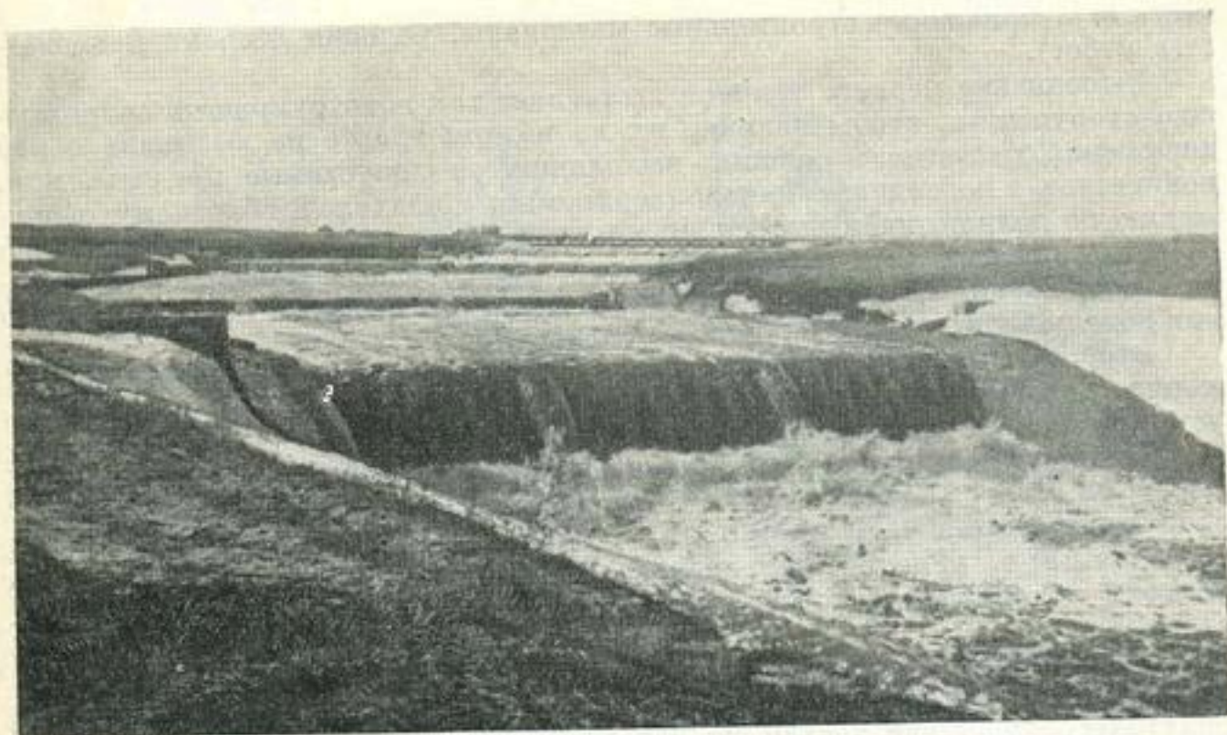
Рис. 6—4. Пропуск весеннего паводка через многоступенчатый перепад.
