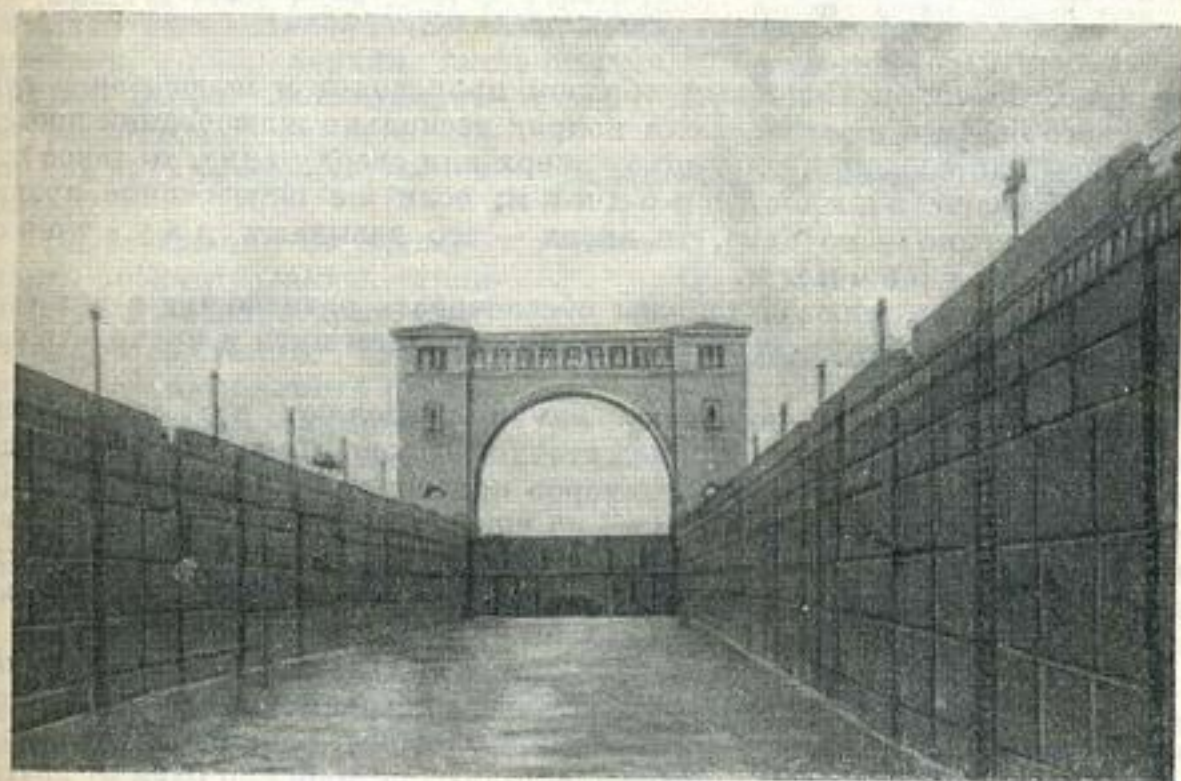
Рис. 25—4. Камерный судоходный шлюз.
