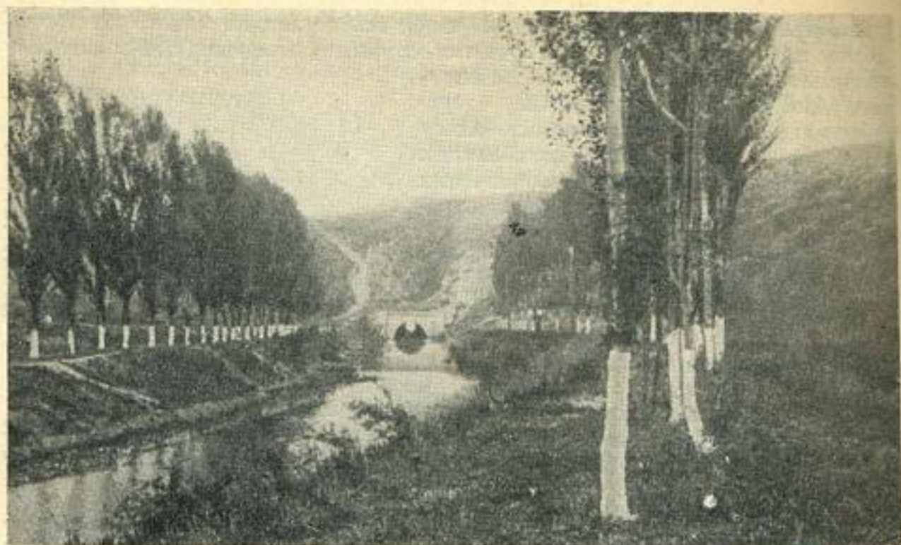
Рис. 5—31. Вход оросительного канала в туннель.
