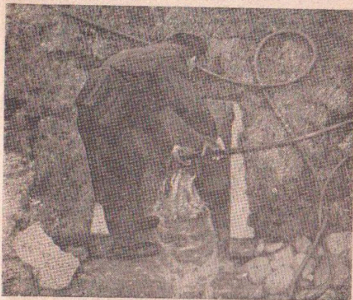
Рис. 20. Очистка дрен на опытном участке «Слоусть».
