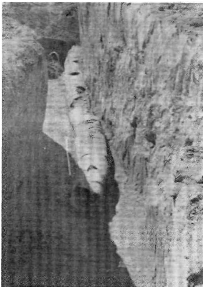
Рис. 2. Водоотвод из керамических труб-кубуров (X—XII вв.) (с. 53)
