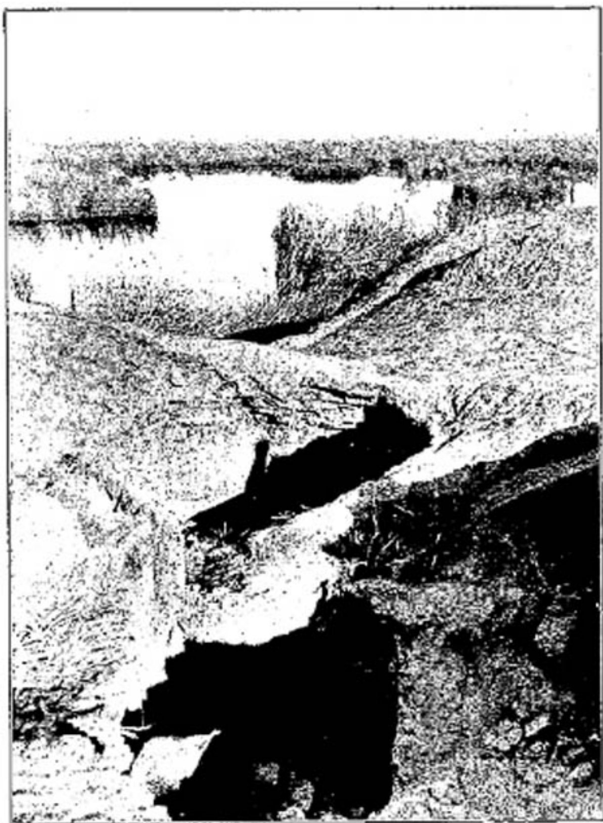
Разрушение берегов сбросными водами.
