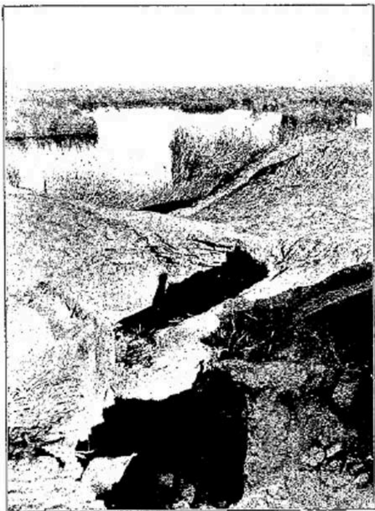
Разрушение берегов сбросными водами.
