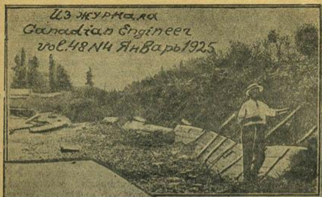
Рис. 2 Временная защита подошвы берега
