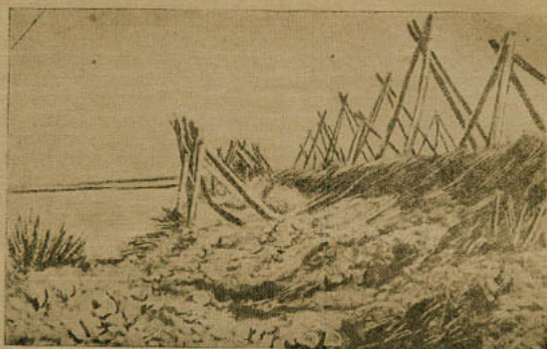
Рис. 2. Укрепление Чуджинской дамбы
