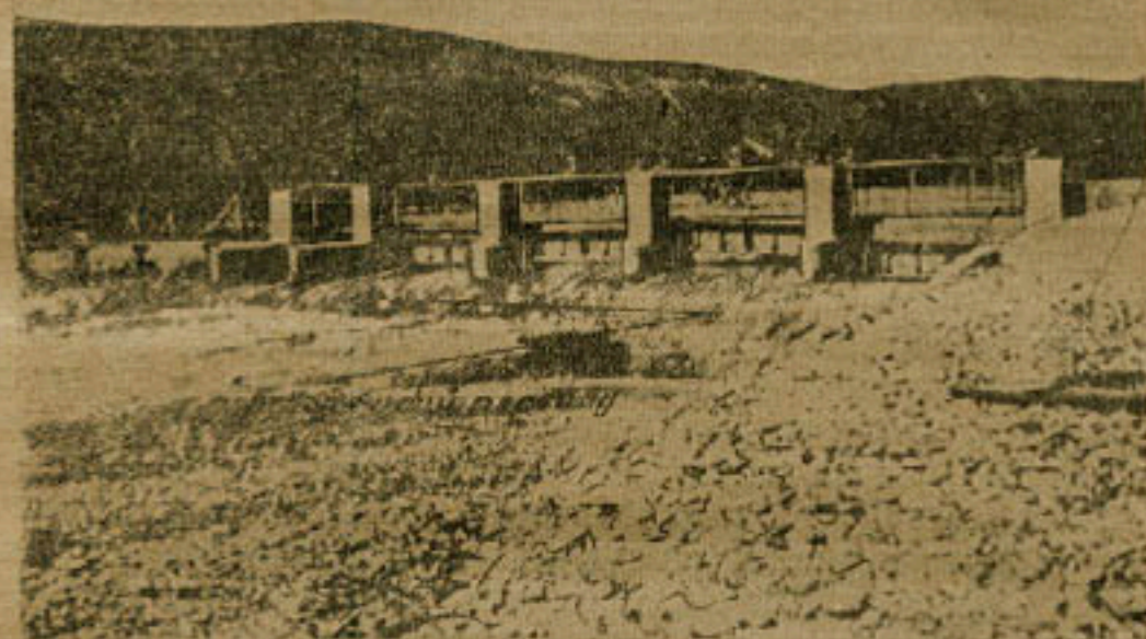
Рис. 6. Вид на плотину с нижнего бьефа после разрушения сливного хода, ясно виден „вторичный перепад“ 1934 г.
