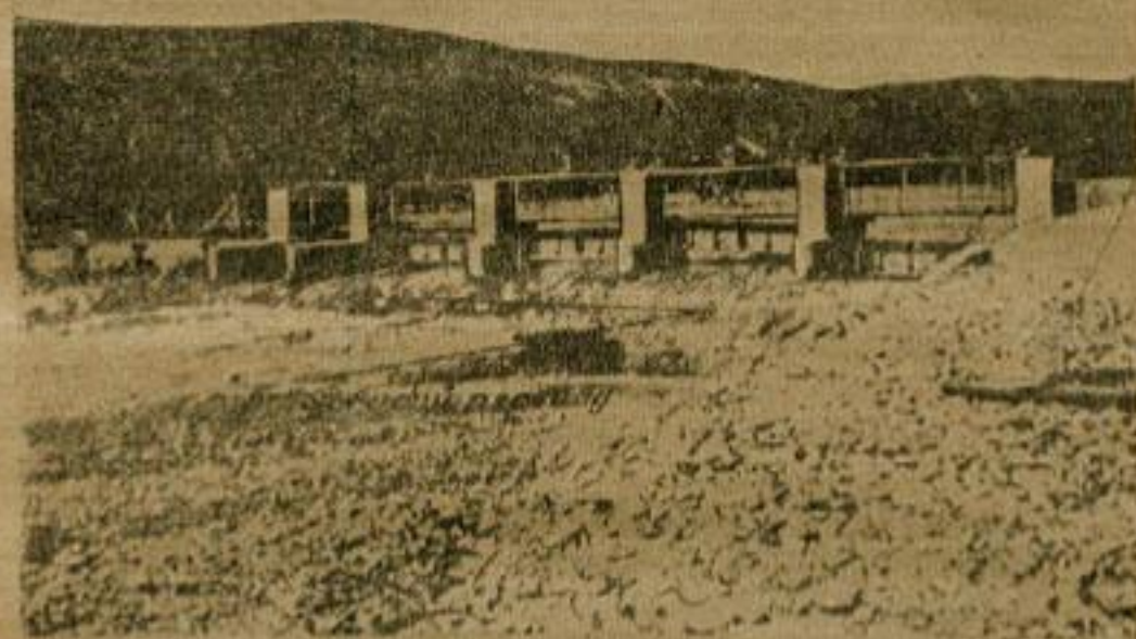
Рис. 6. Вид на плотину с нижнего бьефа после разрушения spillway хода, ясно виден „вторичный перепад“ 1934 г.
