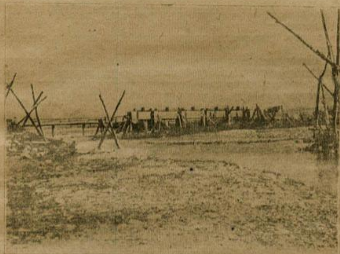
Рис. 3. Общий вид плотины на реке Кутарт-сай (1935 г.) с нижнего бьефа
