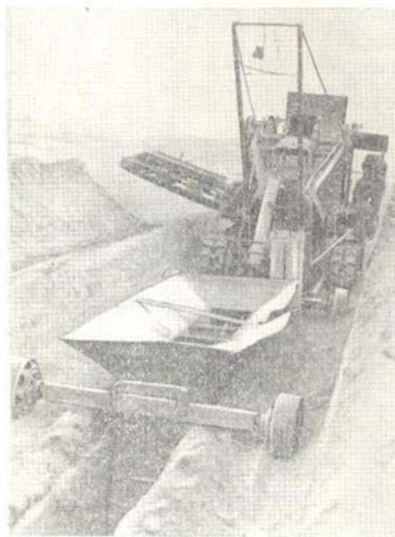
Рис. 3. Дренопрокладчик Д-251 в работе.
