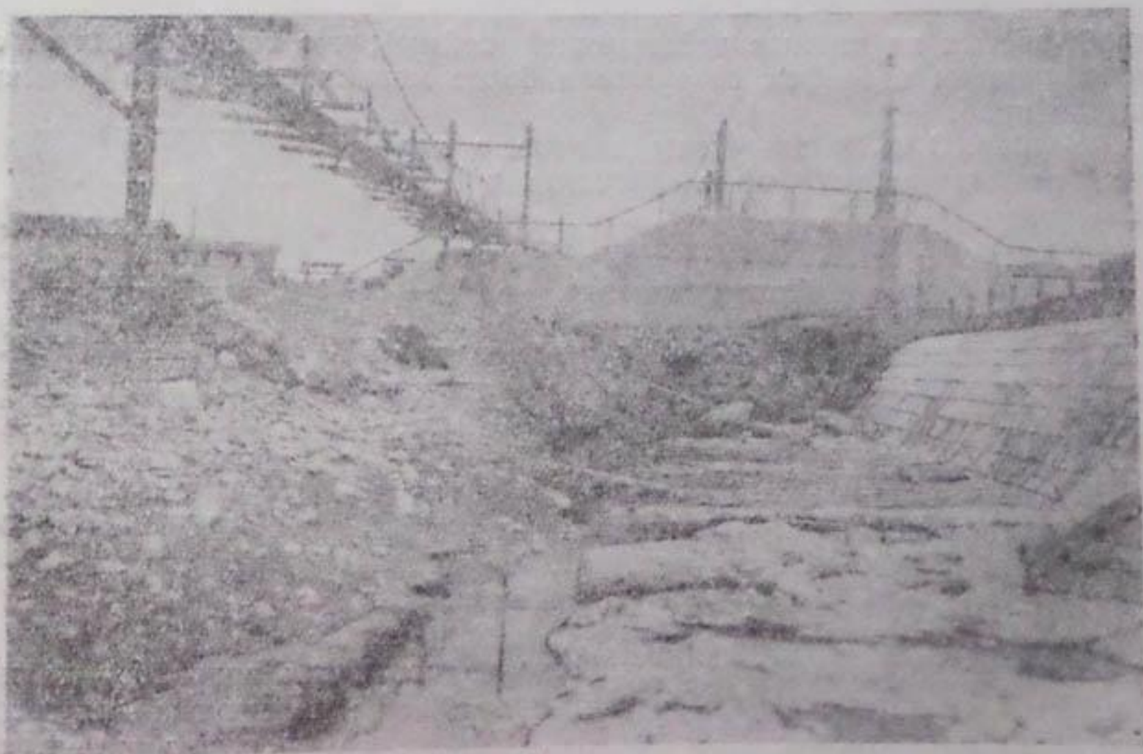
Рис. 18. Занесение нижнего бьефа у правой стороны водослива.
