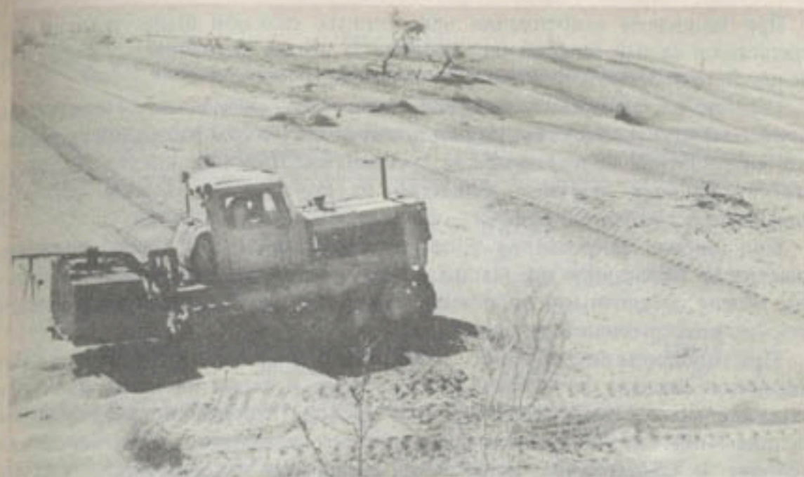
Рис. 19. Нанесение вяжущих веществ на песчаную поверхность.
