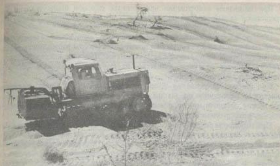
Рис. 19. Нанесение вяжущих веществ на песчаную поверхность.
