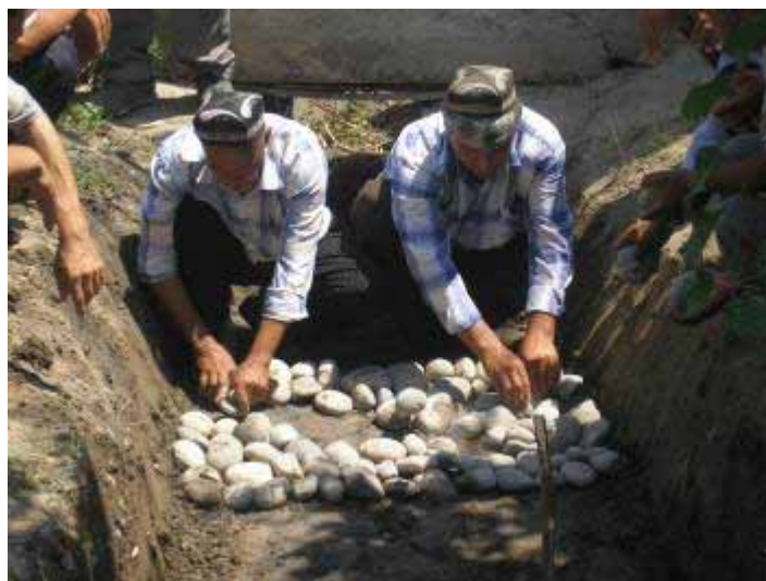
Рис.12. Укладка каменной наброски под основание водомерного устройства.
