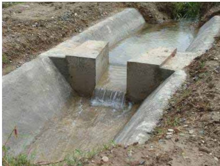
Рис. 6. Гидропост с ВЛС, вид с нижнего бьефа
