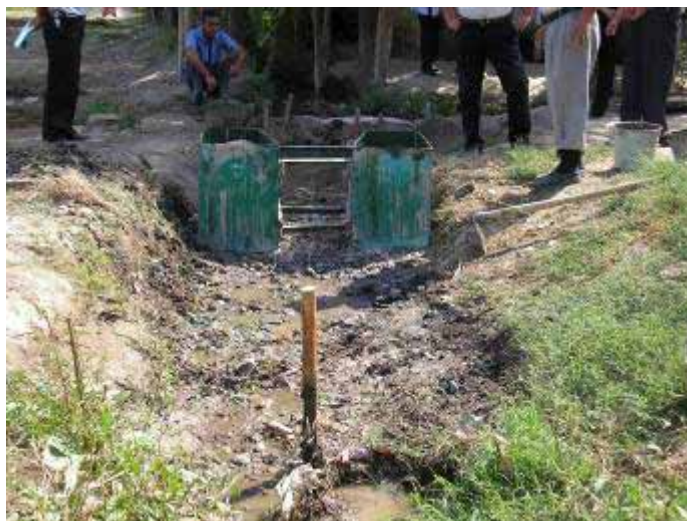
Рис. 13. Установка металлической опалубки для лотка САНИИРИ по оси участка канала.
