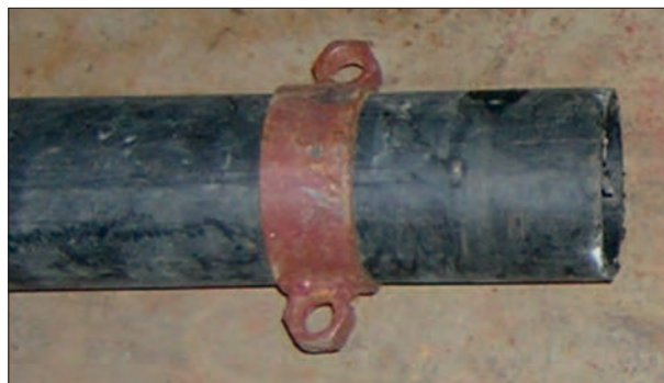
Рис.5.10. Установка хомута на трубе
