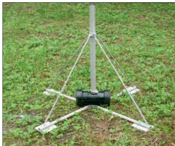
Рис. 5.8. Установка стояка в муфте
