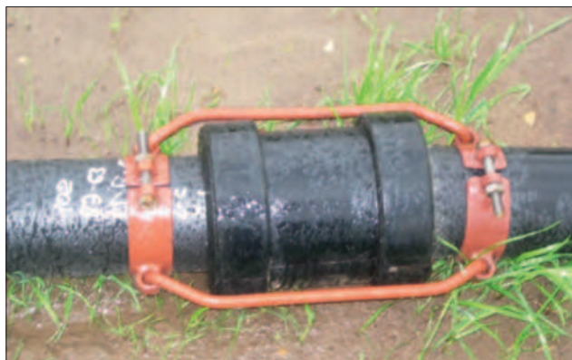
Рис. 5.5. Соединение труб в муфте
