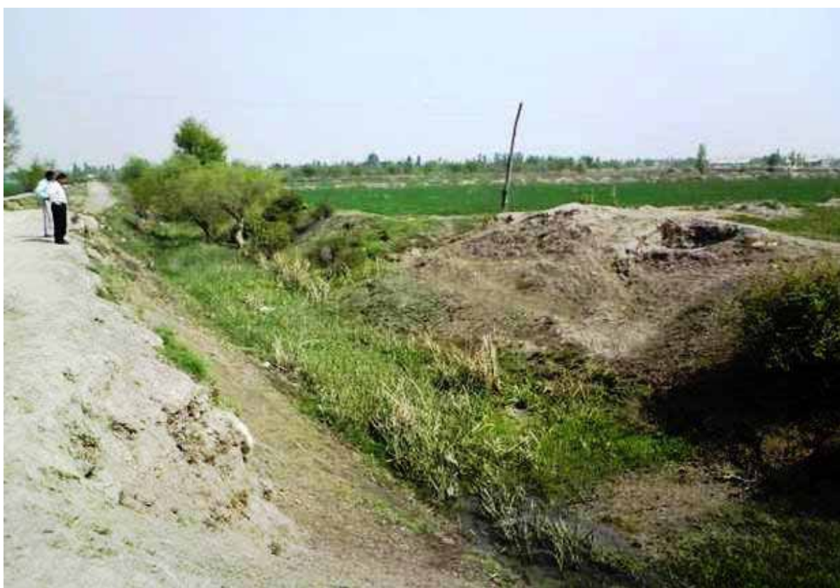
Рис. 4. Характерные недостатки открытой коллекторно-дренажной сети.
