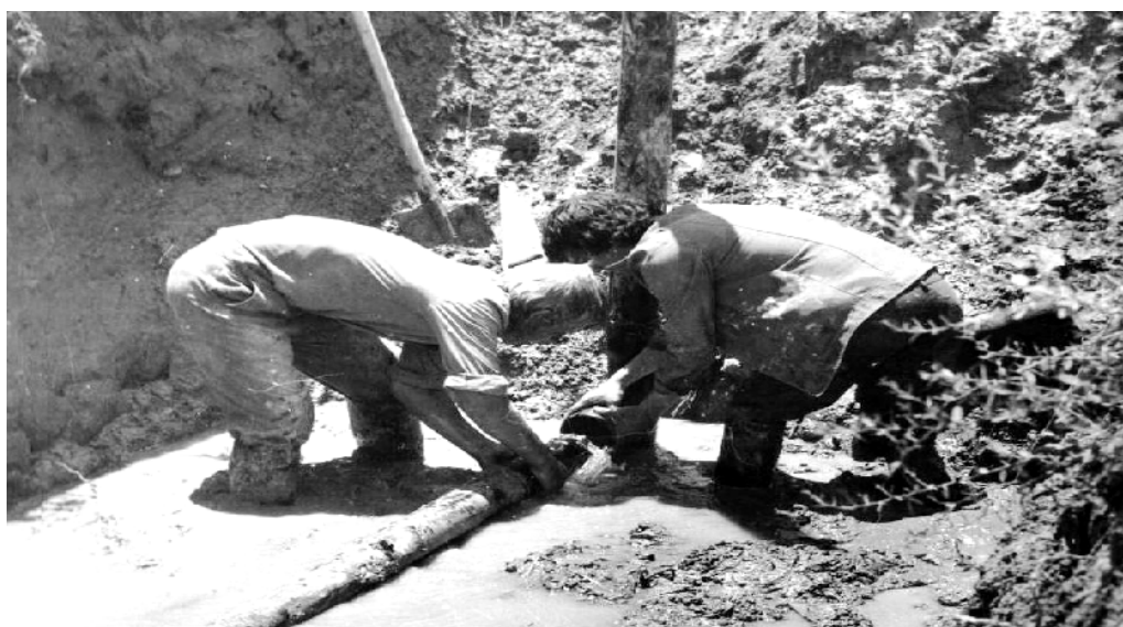
Рис.19. Процесс подключения вертикальных скважин-усилителей к горизонтальной сети.
