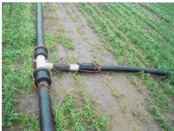
Рис.2. Установка тройника на распределительном трубопроводе
