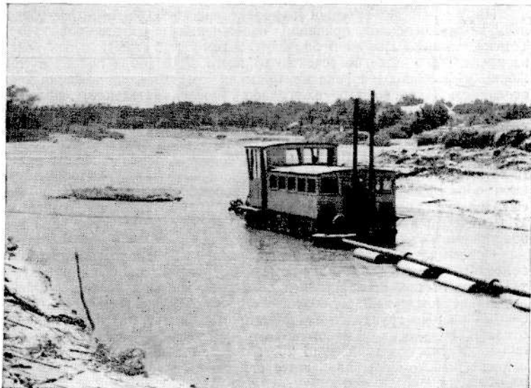
Рис. 38. Расчистка входа в ковш на р. Алей с использованием универсальной плавучей машины УПМ-2
