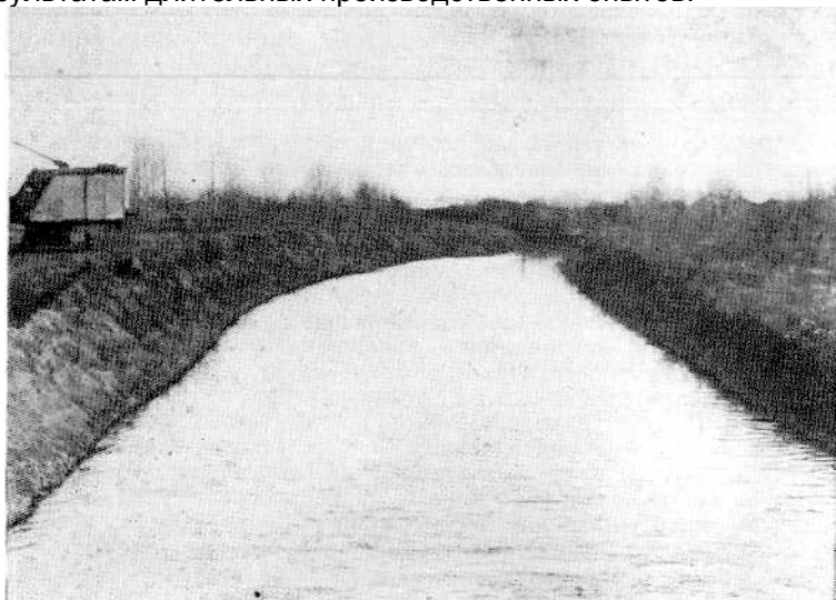
Рис. 80. Инфильтрационный канал на водозаборе из р. Томь
