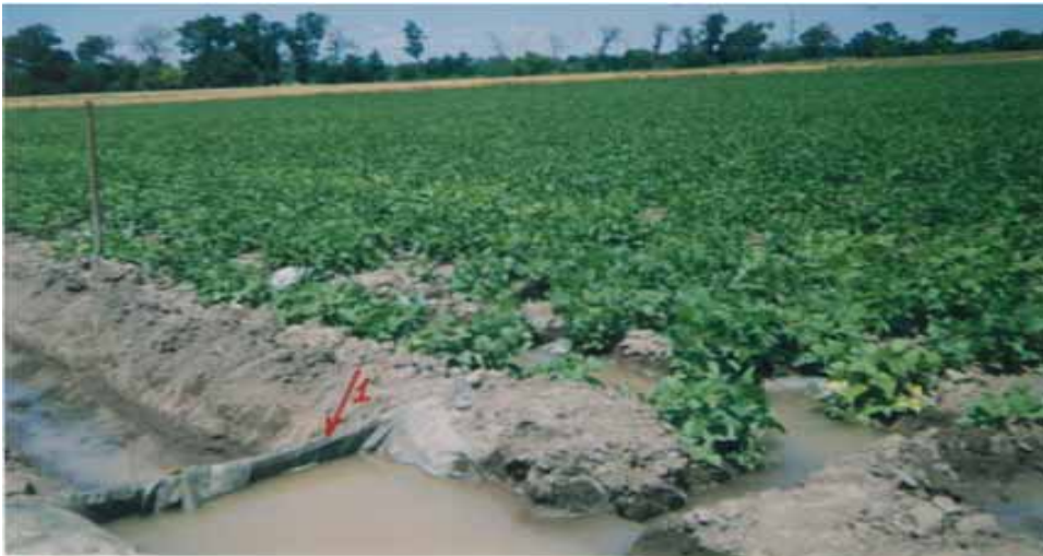
Фото 7. Гибкий перегораживающий подпорный щит – регулятор расхода воды
