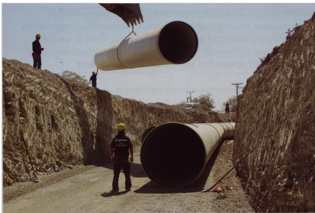
Рисунок 2 – Монтаж трубопровода из стеклопластиковых труб
