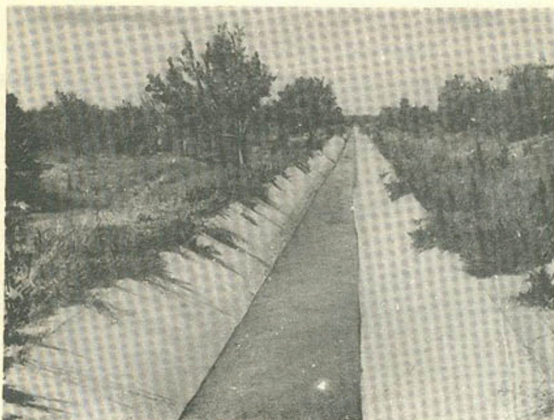
Рис. 32. Канал МК-1 Бендерской оросительной системы
