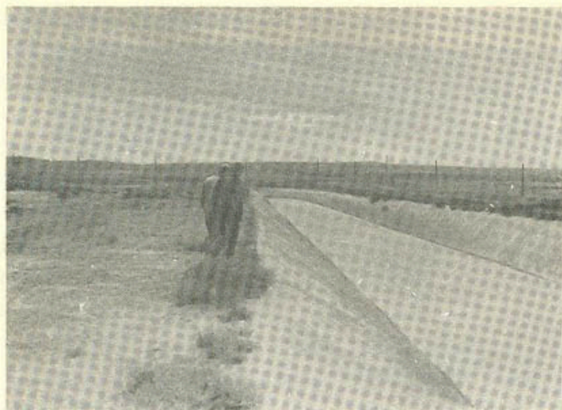
Рис.16. Облицовка Апшеронского канала
