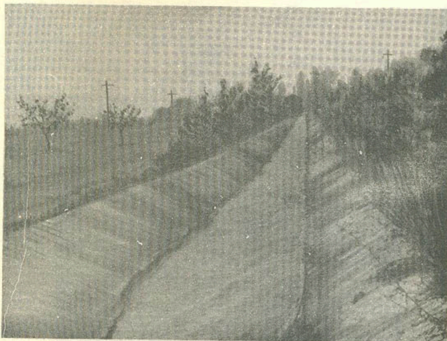
Рис.29. Канал МАК. Монолитная облицовка
