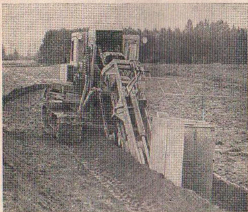
Рис. 26. Экскаватор ЭТЦ-202 в работе.
