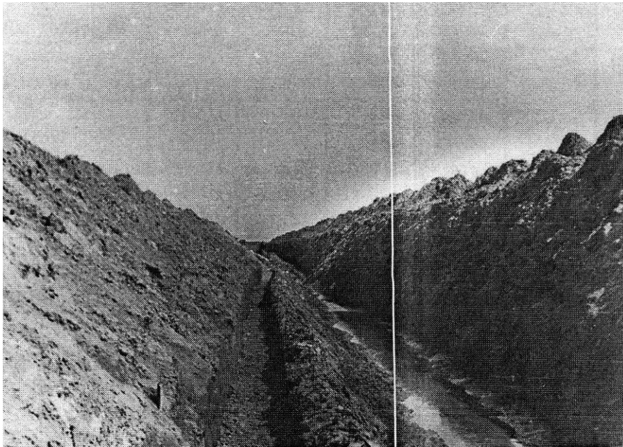
Рис. 3.12. Ложе на откосе траншеи для укладки дрены из труб с фасками
