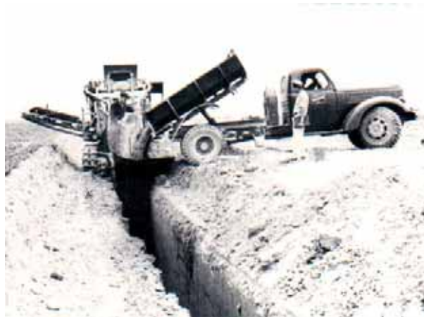
Рис. 1.19. Доставка с приобъектного склада и загрузка бункера дреноукладчика материалом фильтра с помощью автосамосвала
