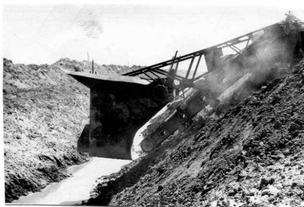
Рис. 1.15. Применение траншейных дреноукладчиков при устройстве приустьевой части дрены
