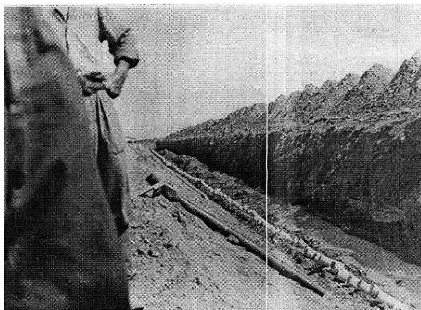
Рис. 3.13. Раскладка дренажных фасочных труб по трассе дрены
