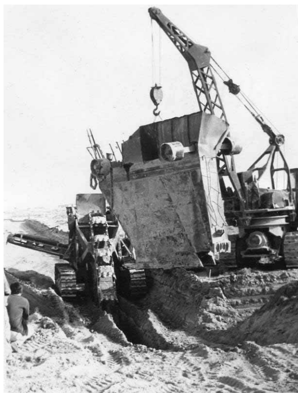
Рис. 1.18. Перемещение дренажного устройства с демонтажем бункера
