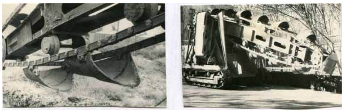
Рис. 5.8 б. Роющий орган траншейного дреноукладчика с полукруглыми ковшами
