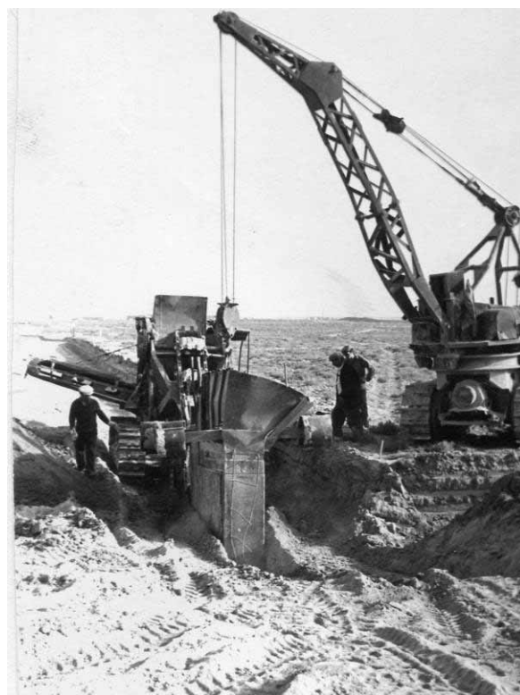
Рис. 1.18. Перемещение дренажного устройства с демонтажем бункера
