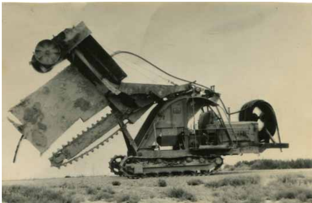
Рис.1.26. Экспериментальный дренаукладчик ДЩ-251 в транспортном положении
