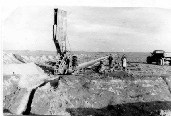
Рис. 1.15. Применение траншейных дреноукладчиков при устройстве приустьевой части дрены
