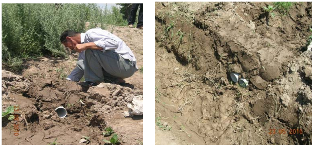
Фото 3. Вода в борозды поступают через поливные трубы диаметром 75 мм, а в поперечные оросители через двойные трубки.
