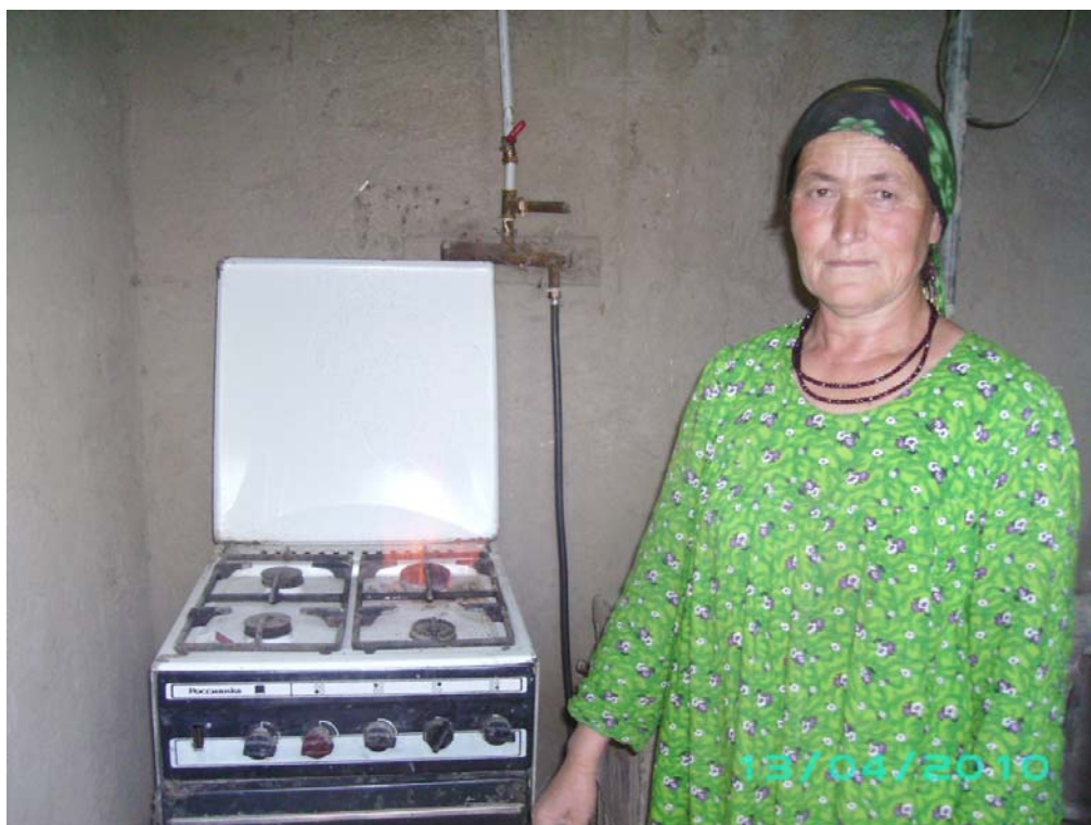
Фото 3. Демонстрация пламя от биогаза на кухонной плите.
