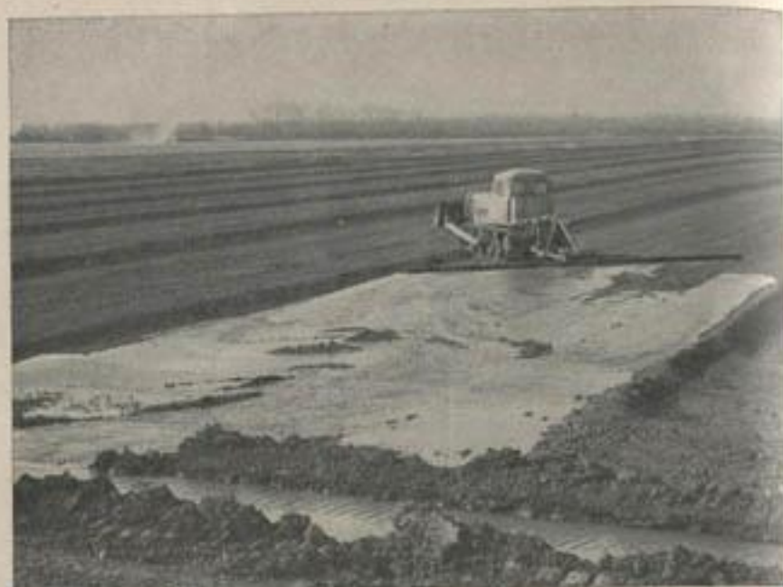
Рис. 25. Влагозарядка с помощью бульдозера.
