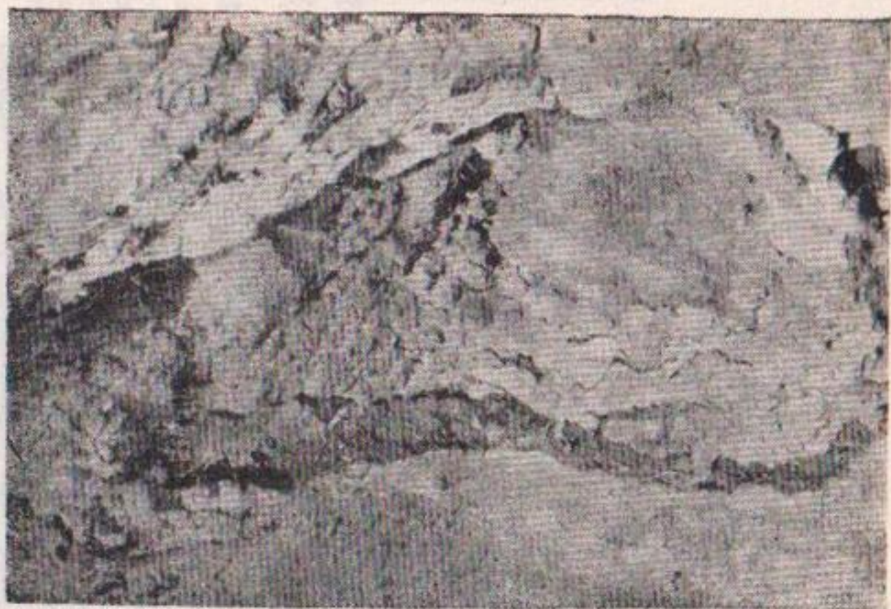
Рис. 7. Воронка обрушения на линии горизонтального дренажа.
