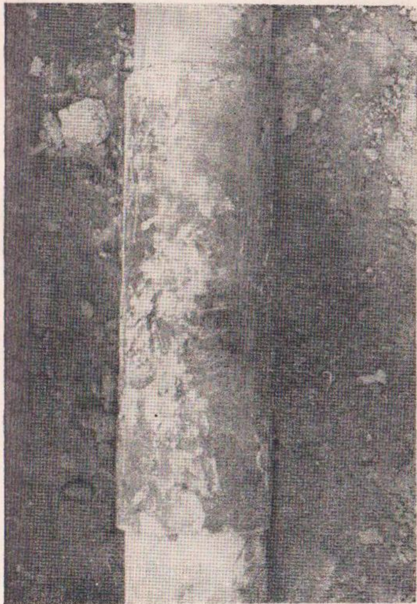
Рис. 28. Узел соединения вертикальной дрены с собирателем.
