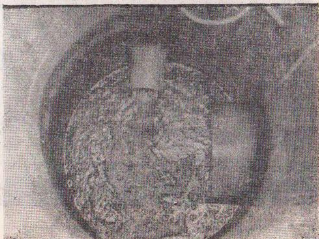
Рис. 2. Сопряжение устья собирателя закрытой дрены с закрытым коллектором.
