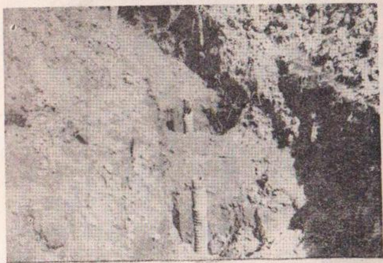
Рис. 46. Траншея кольцевого собирателя и вертикальные дрены, установленные способом гидроразмыва.
